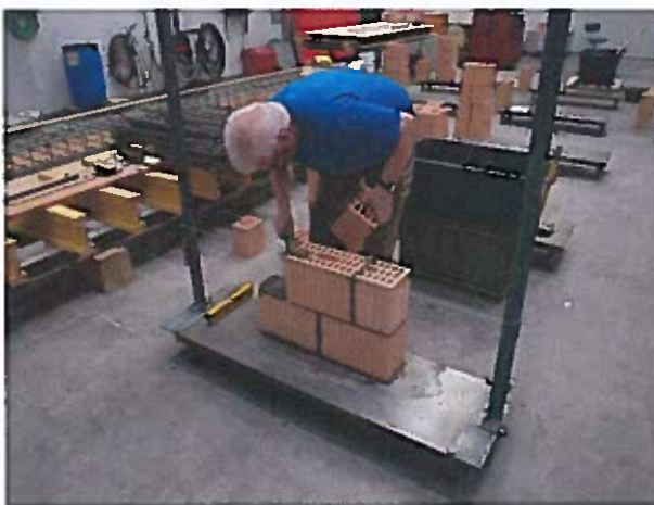
Abbildung 1: Aufmauern eines Mauerwerkskleinkörpers der ersten Prüfserie.
